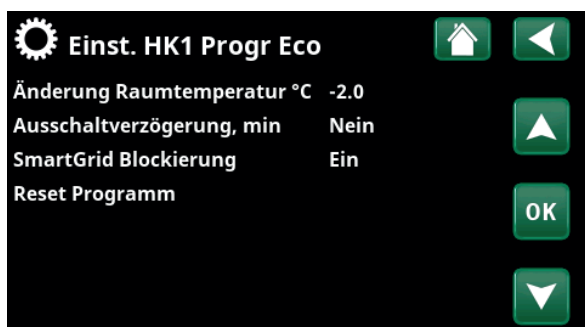
Menü „Erweitert/Einstellungen/Heizkreis/Heizkreis 1/Programm/Eco“.
