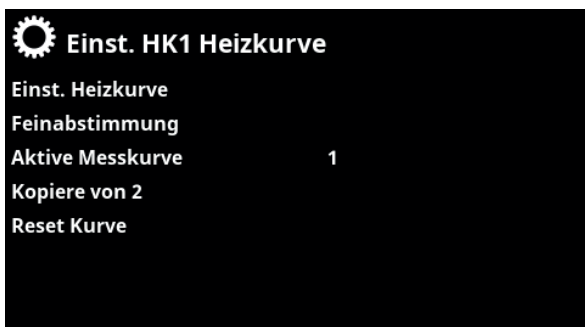
Menü „Erweitert/Einstellungen/Heizkreis/Heizkreis 1/Heizkurve“. Aktive Messkurve: #1.
